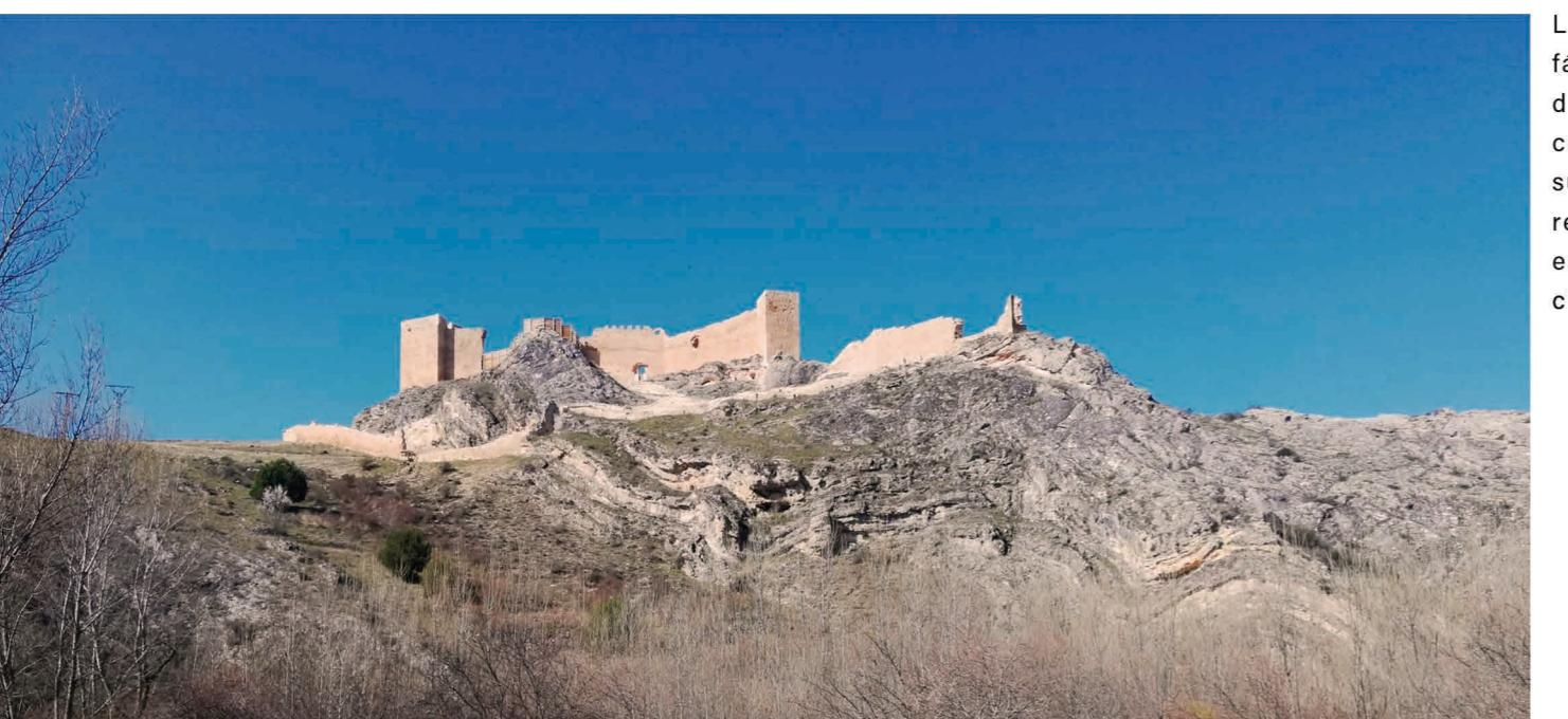
Alzado sur con restauración de fábricas y recuperación de los elementos perdidos con madera
