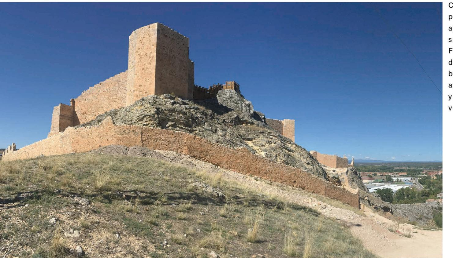
Alzado suroeste con restauración de fábricas y recuperación de los elementos perdidos con madera
