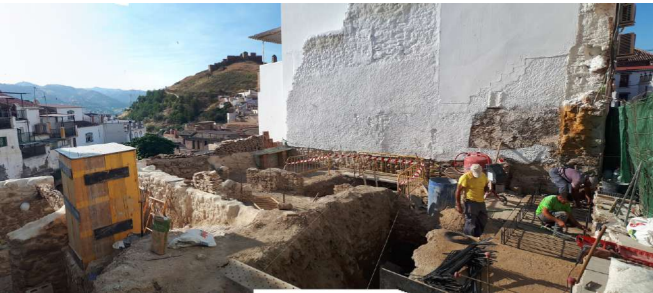
Obra: Solar excavado. Ejecución de los muros de fachada
