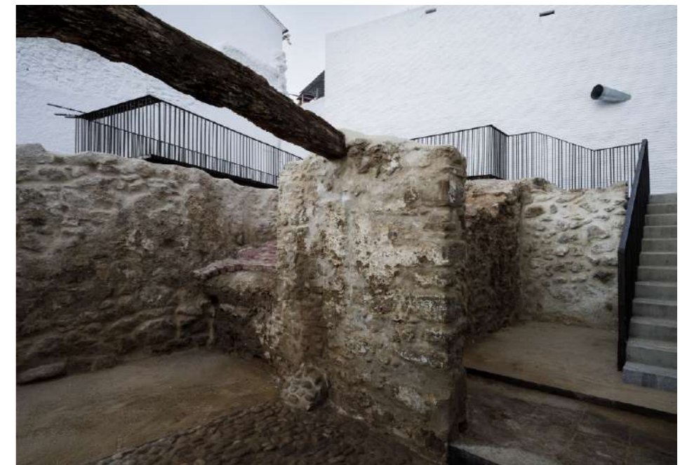
Estado reformado: Interior. Vista desde el establo. Recorrido de texturas
