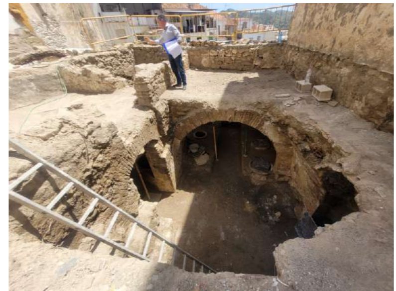
Obra: Descubrimiento de la despensa abovedada
